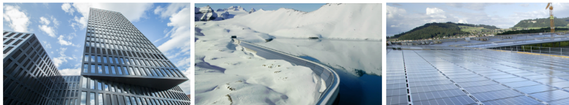
Bilder: BIPV-Solarkraftwerk Grosspeter Tower Basel, Solarkraftwerk KLL-Staumauer Muttssee, Stadion-Solarkraftwerk ‚Stade de Suisse‘ Bern.
